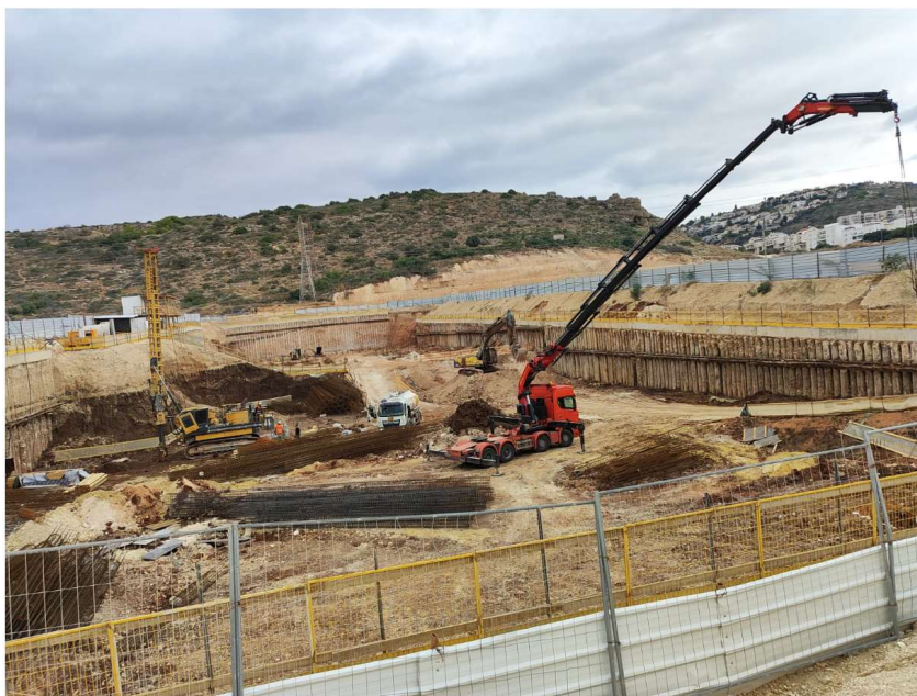
מגרש 220, הושלכו 95 מה כלונסאות חופרים לראשי כלונס. מגרש 219 קוודים כלונסאות ביסוס.
