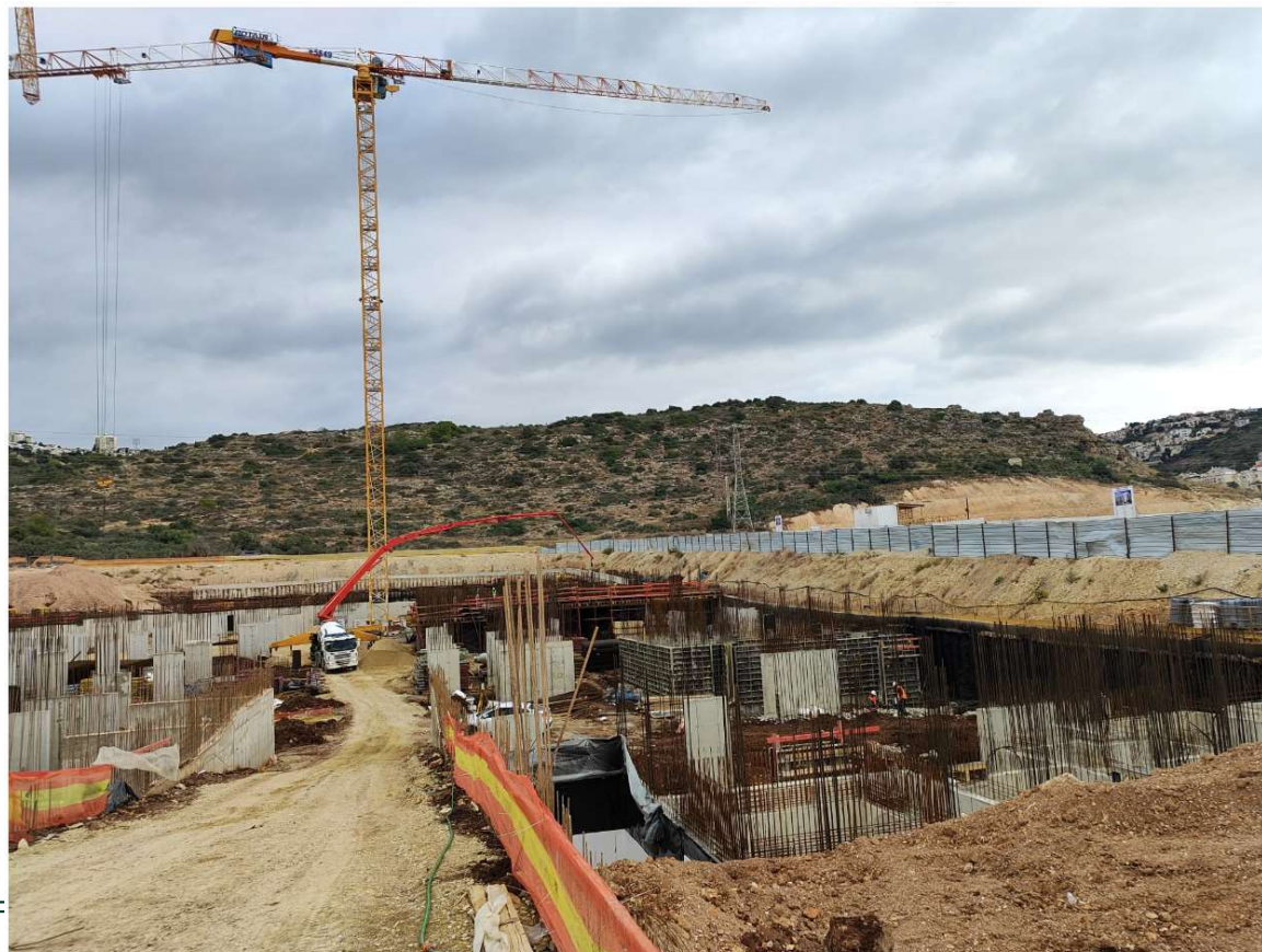
מגרש 218, יציקת תקרה במפלס 1- של מגדל 45 כולל השלמת יציקת קירות כל המכנים הנמוכים ו עמודי חניון למפלס 1-
